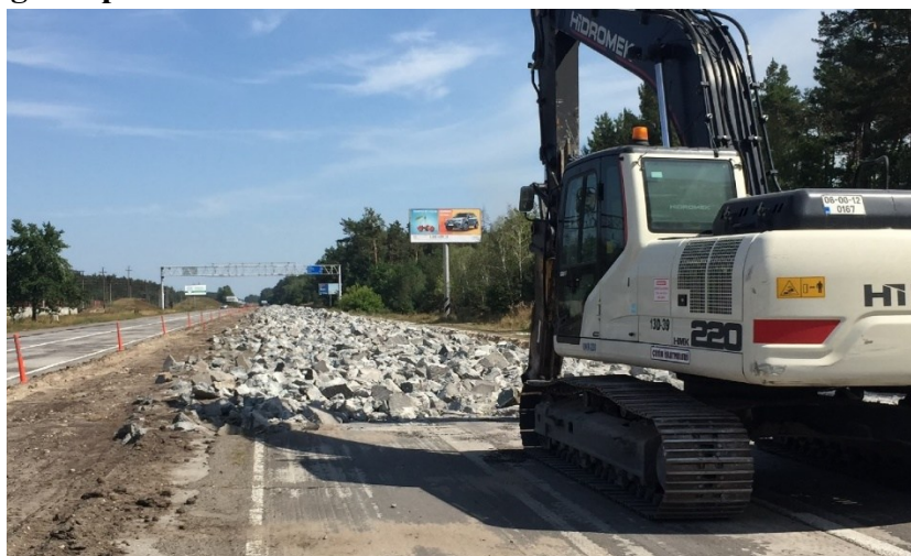
Figură 4-10: Spargerea plăcilor de beton cu ciocanul hidraulic
