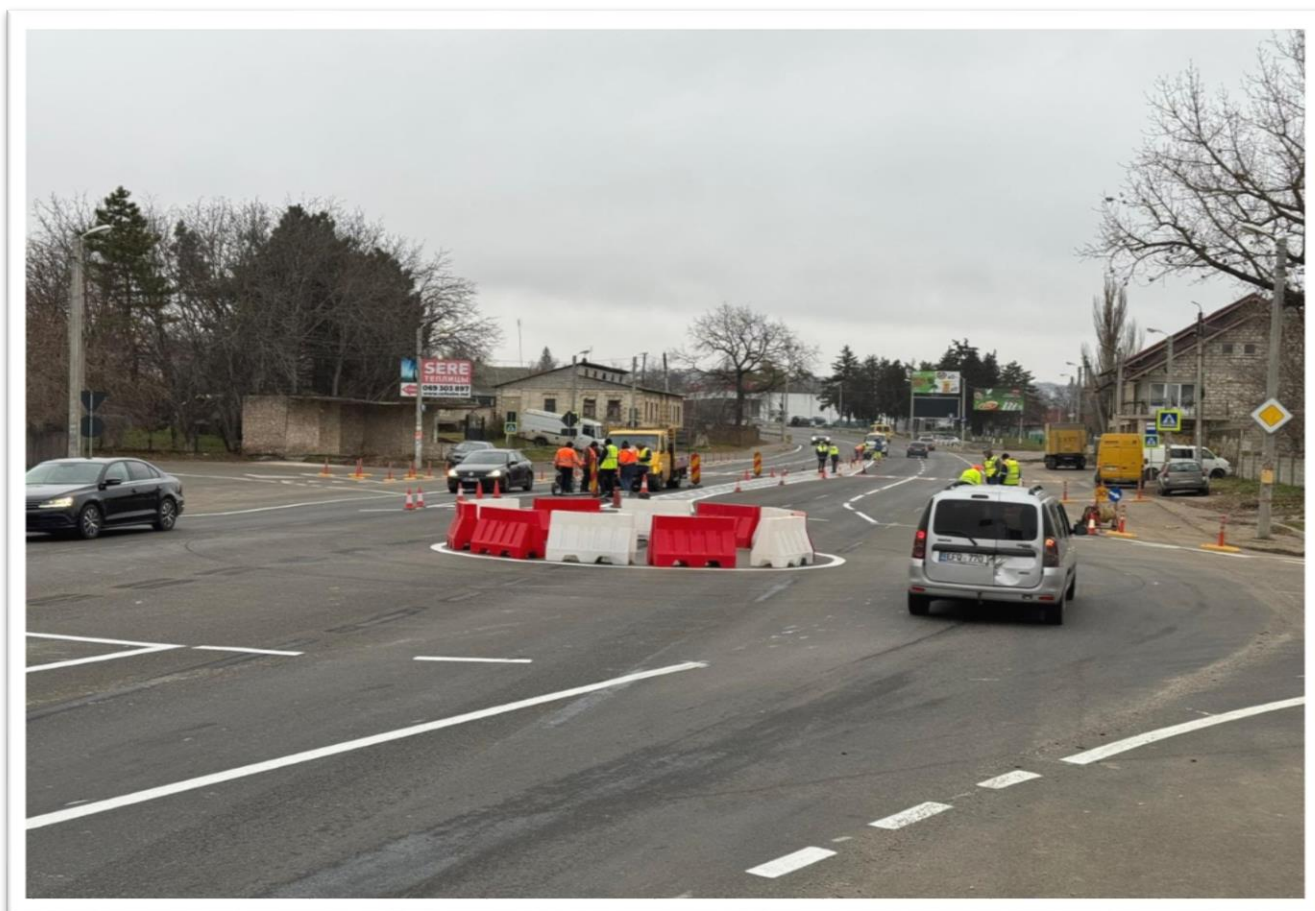
Figura 3. Intersecția drumurilor publice naționale R6 Chișinău – Orhei – Bălți, km 27,700 cu drumul de acces către s. Micleşti, după amenajarea cu sensuri giratorii provizorii.
