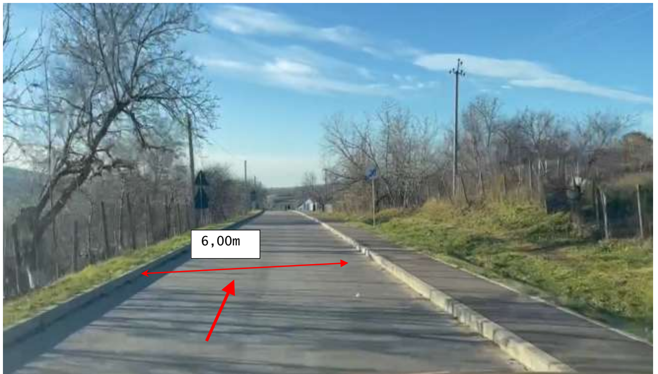
Figura 62. Km 11+050. Sector reabilitat în cadrul proiectului de reparație a drumului, sistemul rutier existent din beton asfaltic în stare satisfăcătoare. Partea carosabilă este mărginită cu piatră de bordură pe ambele părți și trotuar pe partea dreaptă.
