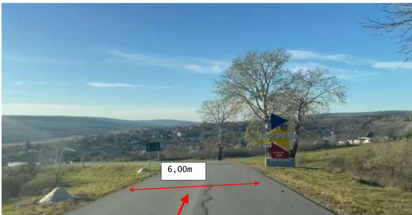
Figura 51. Km 9+400. Începutul localității Coropcenii. Sector reabilitat în cadrul proiectului de reparație a drumului, sistemul rutier existent din beton asfaltic în stare satisfăcătoare. Lățimea carosabilului existent ~6.00 m cu acostamente neconsolidate cu piatră spartă cu depuneri locale de namol. Tasări longitudinale pe lungimea 100 m în axul drumului datorată necompactării corespunzătoare a patului drumului sau a infiltrării apelor pluviale de pe versanții din amonte drumului (lipsește șanțul pentru evacuarea apelor meteorice).
