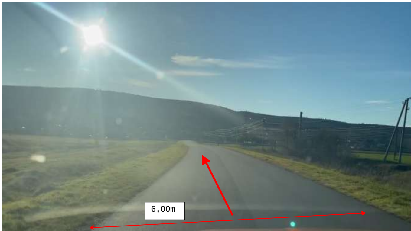
Figura 34. Km 5+700. Sector reabilitat în cadrul proiectului de reparație a drumului, sistemul rutier existent din beton asfaltic în stare bună. Lățimea carosabilului existent ~6.00 m cu acostamente neconsolidate cu piatră spartă cu depuneri locale de namol.
