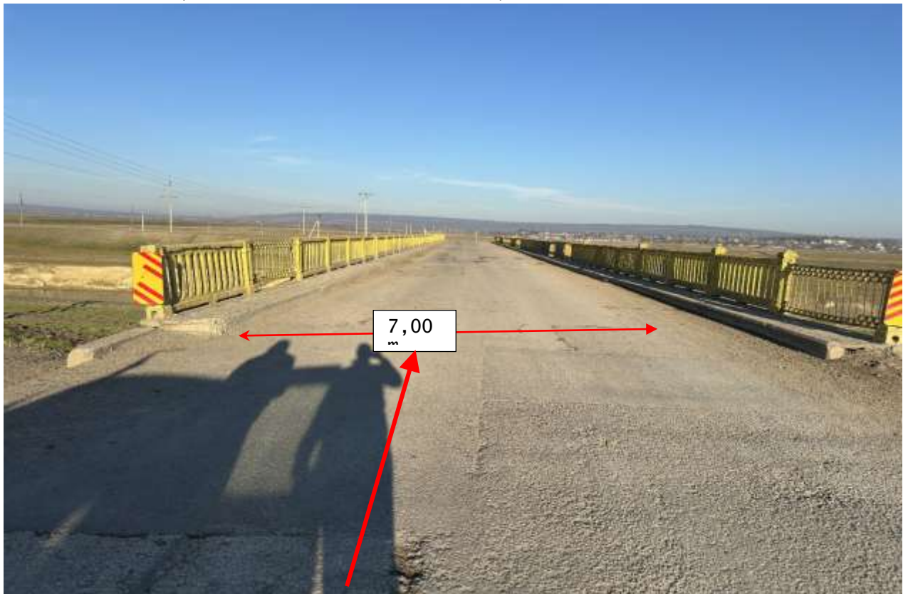
Figura 22. Km 3+953,50. Racordarea terasamentului drumului cu podul peste râul Răut. Lățimea carosabilului existent 7.00 m carosabil delimitat cu piatră de bordură și trotuar tehnic. Pentru a putea evalua starea tehnică a acestui pod este necesar de executat raport de expertiză. Carosabilul de pe calea podului este în stare foarte rea și stagnează evacuarea apei pluviale.
