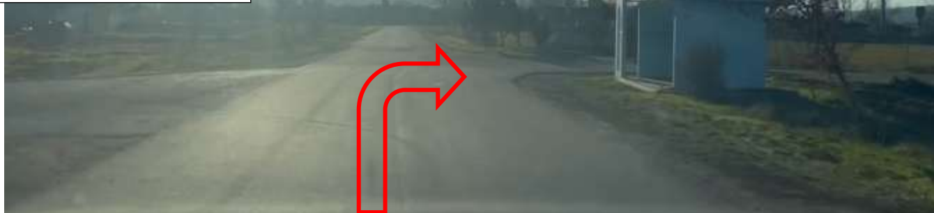
Figura 11. Km 1+200. Sector reabilitat în cadrul proiectului de reparație a drumului, sistemul rutier existent beton asfaltic în stare bună. Lățimea carosabilului existent ~6.00 m cu acostamente neconsolidate cu piatră spartă cu depuneri locale de namol.
