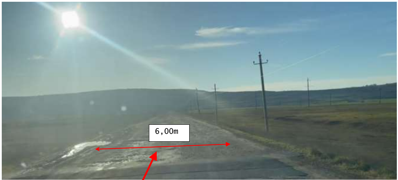
Figura 26. Km 4+450. Sistemul rutier existent beton vibrocilindrat în stare rea. Lăţimea carosabilului existent ~6.00 m cu acostamente neconsolidate cu piatră spartă cu depuneri locale de namol.
