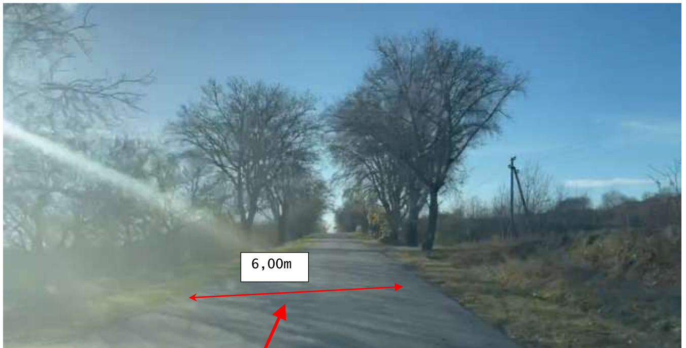
Figura 44. Km 7+600. Sector reabilitat în cadrul proiectului de reparație a drumului, sistemul rutier existent din beton asfaltic în stare satisfăcătoare. Lățimea carosabilului existent ~6.00 m cu acostamente neconsolidate cu piatră spartă cu depuneri locale de namol. Lipsește șanțurile laterale cu consolidare conform tipurilor.
