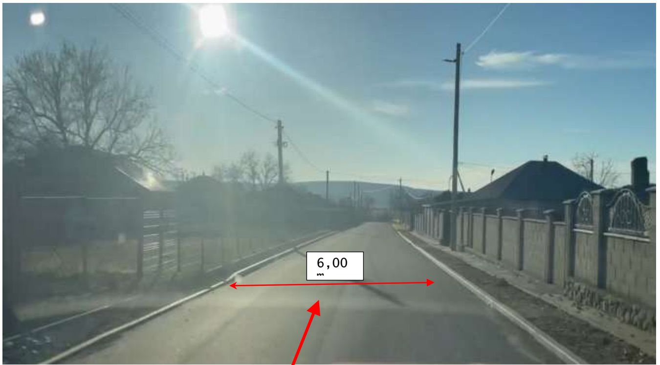
Figura 17. Km 2+125. Sector reabilitat în cadrul proiectului de reparație a drumului, sistemul rutier existent beton asfaltic în stare bună. Lățimea carosabilului existent ~6.00 m. Partea stângă și dreaptă este amenajată piatră de bordură cu trotuar nefinalizat pe stînga. Evacuarea apelor de pe carosabil sunt direcționate în longitudinalul drumului spre străzile laterale.
