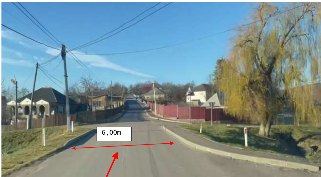
Figura 57. Km 10+300. Sector reabilitat în cadrul proiectului de reparație a drumului, sistemul rutier existent din beton asfaltic în stare satisfăcătoare. Partea carosabilă este mărginită cu piatră de bordură pe ambele părți și trotuar pe partea dreaptă.
