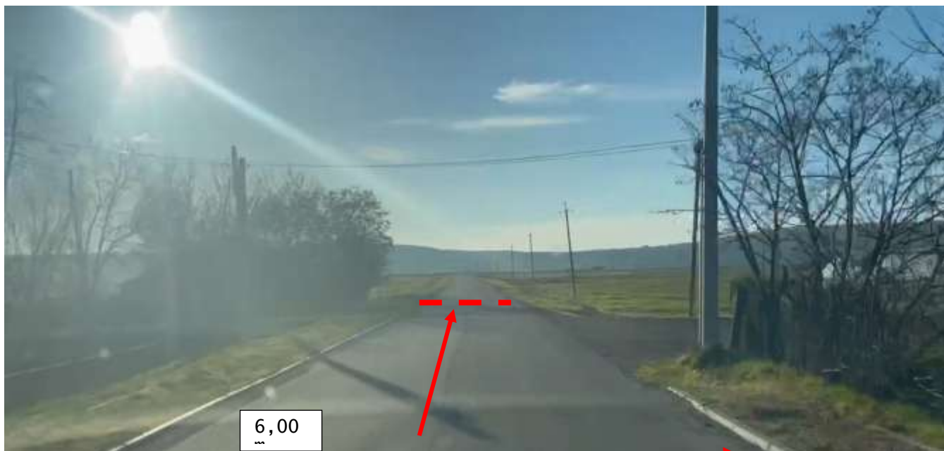
Figura 19. Km 2+650. Sector reabilitat în cadrul proiectului de reparație a drumului, sistemul rutier existent beton asfaltic în stare bună. Lățimea carosabilului existent ~6.00 m. Partea stângă și dreaptă este amenajată piatră de bordură cu trotuar nefinalizat. Evacuarea apelor de pe carosabil sunt direcționate în longitudinalul drumului spre străzile laterale. De specificat că bordurile la intrările în curți sunt montate înecat. Accesele spre curți nu sunt executate.
