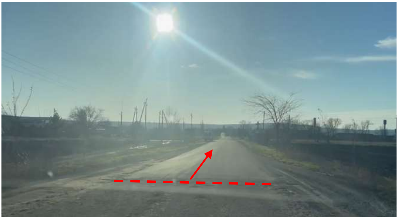
Figura 10. Km 1+105,5. Început sector reabilitat în cadrul proiectului de reparație a drumului G66 R6-Clisova-Sărătenii Noi-R22, km 0,00- km 11,40 (denumirea Veche L326 M2-Clisova-Suhuluceni-Leușeni-Verejeni) sistemul rutier existent beton asfaltic în stare bună. Lățimea carosabilului existent ~6.00 m cu acostamente neconsolidate cu piatră spartă cu depuneri locale de namol.
