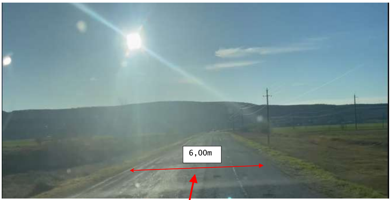
Figura 31. Km 5+050. Sector reabilitat în cadrul proiectului de reparație a drumului, sistemul rutier beton vibrocilindrat existent în stare rea. Lățimea carosabilului existent ~6.00 m cu acostamente neconsolidate cu piatră spartă cu depuneri locale de namol. Pentru a repara acest sector au fost executate lucrări de plombare a rostului longitudinal și pe alocuri și transversal. Aceste rosturi au apărut în perioada de exploatare întrucât la etapa de execuție nu au fost executate.
