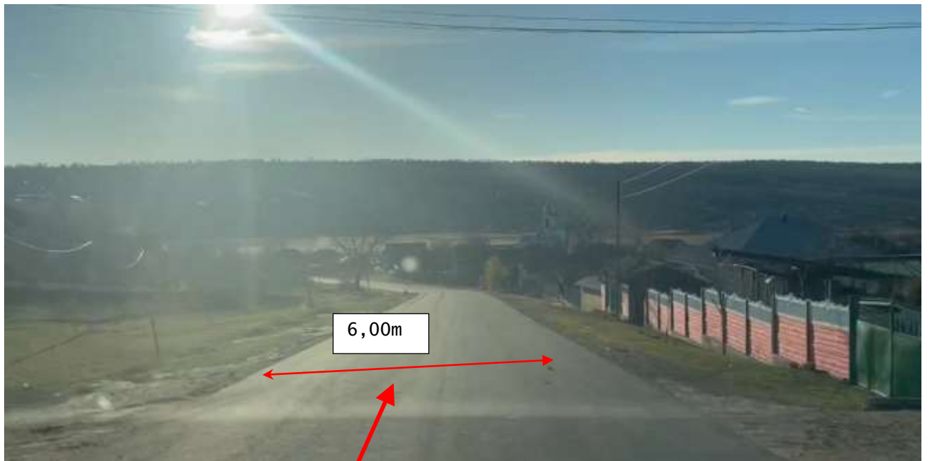
Figura 52. Km 9+975. Sector reabilitat în cadrul proiectului de reparație a drumului, sistemul rutier existent din beton asfaltic în stare satisfăcătoare. Lățimea carosabilului existent ~6.00 m cu acostamente neconsolidate cu piatră spartă cu depuneri locale de namol.
