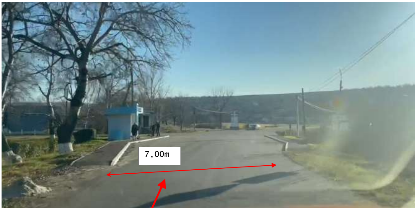
Figura 54. Km 10+000. Sector reabilitat în cadrul proiectului de reparație a drumului, sistemul rutier existent din beton asfaltic în stare satisfăcătoare. Lățimea carosabilului existent ~6.00 m cu acostamente neconsolidate cu piatră spartă cu depuneri locale de namol. Sunt amplasate caile pietonale pentru stațiile de așteptare.
