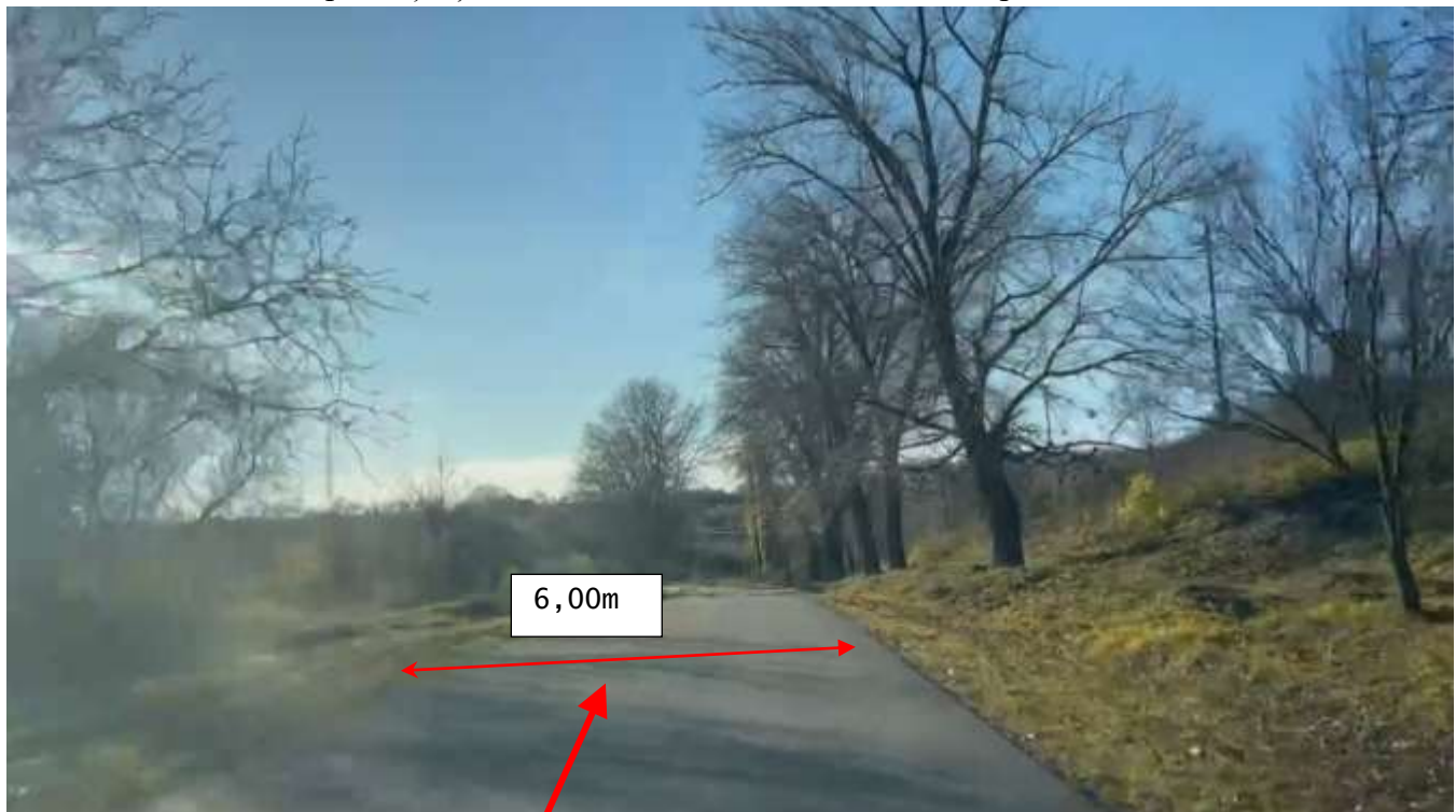
Figura 45. Km 7+950. Sector reabilitat în cadrul proiectului de reparație a drumului, sistemul rutier existent din beton asfaltic în stare satisfăcătoare. Lățimea carosabilului existent ~6.00 m cu acostamente neconsolidate cu piatră spartă cu depuneri locale de namol. Lipsește șanțurile laterale cu consolidare conform tipurilor.
