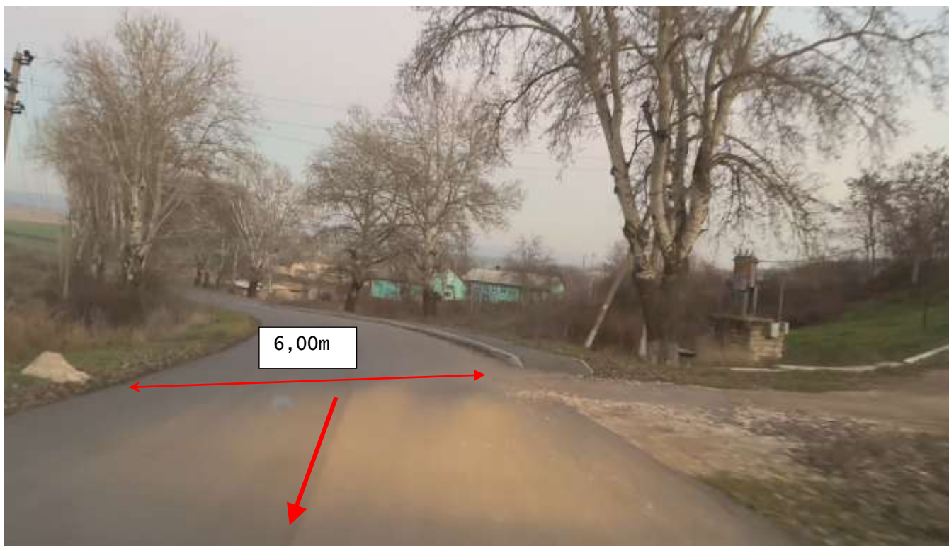
Figura 39. Km 6+570. Sector reabilitat în cadrul proiectului de reparație a drumului, sistemul rutier existent din beton asfaltic în stare bună. Lățimea carosabilului existent ~6.00 m cu acostamente neconsolidate cu piatră spartă. Bordura și trotuarul din partea stângă se finisează.
