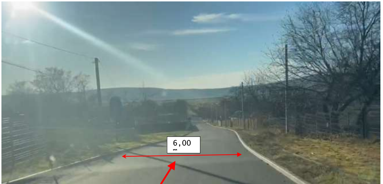
Figura 18. Km 2+325. Sector reabilitat în cadrul proiectului de reparație a drumului, sistemul rutier existent beton asfaltic în stare bună. Lățimea carosabilului existent ~6.00 m. Partea stîngă și dreaptă este amenajată piatră de bordură cu trotuar nefinalizat. Evacuarea apelor de pe carosabil sunt direcționate în longitudinalul drumului spre străzile laterale.
