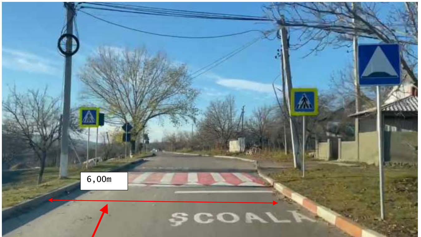
Figura 61. Km 10+850. Sector reabilitat în cadrul proiectului de reparație a drumului, sistemul rutier existent din beton asfaltic în stare satisfăcătoare. Partea carosabilă este mărginită cu piatră de bordură pe ambele părți și trotuar pe partea dreaptă. Este executată denivelare artificială în apropiere de instituția de învățământ din sat. Coropcenii.
