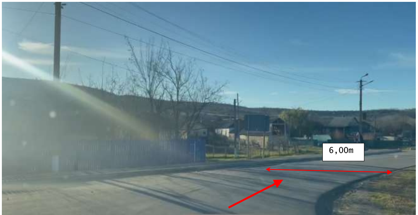
Figura 36. Km 5+925. Sector reabilitat în cadrul proiectului de reparație a drumului, sistemul rutier existent din beton asfaltic în stare bună. Lățimea carosabilului existent ~6.00 m cu acostamente neconsolidate cu piatră spartă. Începutul sectorului cu delimitare a părții carosabile din stînga cu bordură și trotuar intravilanul loc. Clișova.
