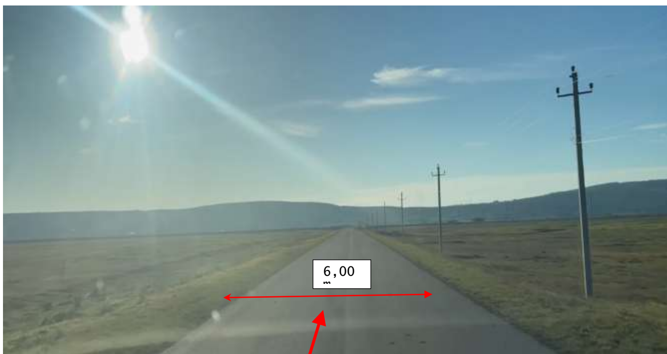
Figura 20. Km 3+125. Sector reabilitat în cadrul proiectului de reparație a drumului, sistemul rutier existent beton asfaltic în stare bună. Lățimea carosabilului existent ~6.00 m cu acostamente neconsolidate cu piatră spartă cu depuneri locale de namol. Evacuarea apelor de pe carosabil sunt direcționate în acostamentele drumului și piciorul taluzului.
