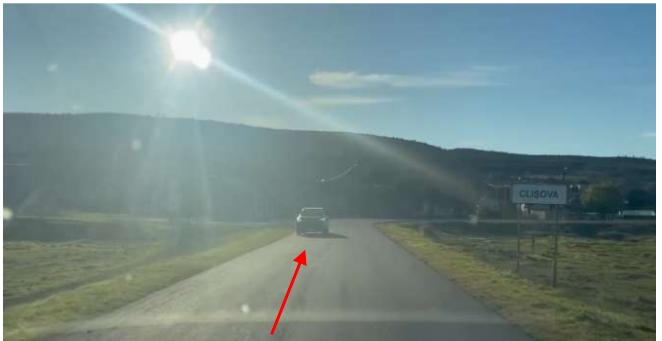
Figura 35. Km 5+860. Sector reabilitat în cadrul proiectului de reparație a drumului, sistemul rutier existent din beton asfaltic în stare bună. Lățimea carosabilului existent ~6.00 m cu acostamente neconsolidate cu piatră spartă cu depuneri locale de namol. Începutul loc. Clișova amenajată tangențial pe partea stîngă a drumului G66.
