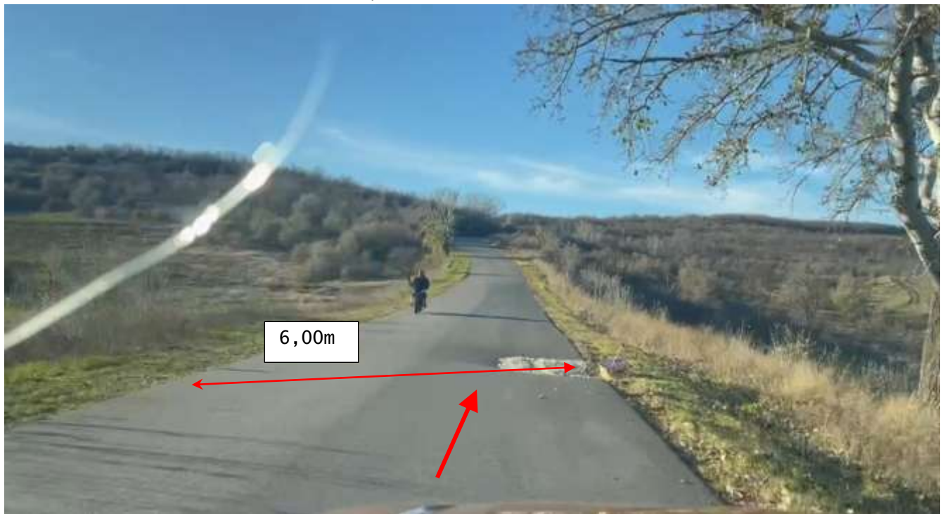
Figura 41. Km 6+980. Sector reabilitat în cadrul proiectului de reparație a drumului, sistemul rutier existent din beton asfaltic în stare satisfăcătoare. Lățimea carosabilului existent ~6.00 m cu acostamente neconsolidate cu piatră spartă cu depuneri locale de namol.
