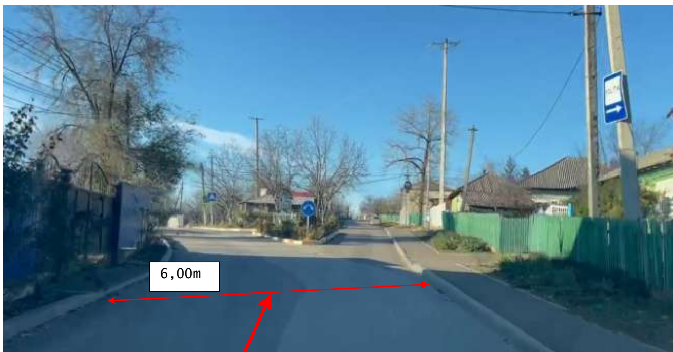
Figura 60. Km 10+800. Sector reabilitat în cadrul proiectului de reparație a drumului, sistemul rutier existent din beton asfaltic în stare satisfăcătoare. Partea carosabilă este mărginită cu piatră de bordură pe ambele părți și trotuar pe partea dreaptă. Intersecție cu stradă locală executată prin insule de direcționare.
