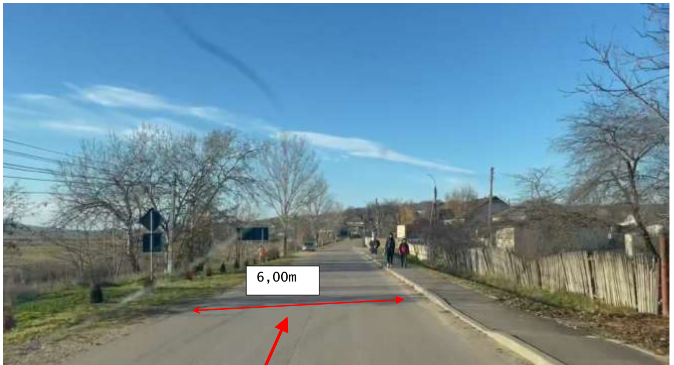
Figura 56. Km 10+050. Sector reabilitat în cadrul proiectului de reparație a drumului, sistemul rutier existent din beton asfaltic în stare satisfăcătoare. Partea carosabilă este mărginită cu piatră de bordură și trotuar.
