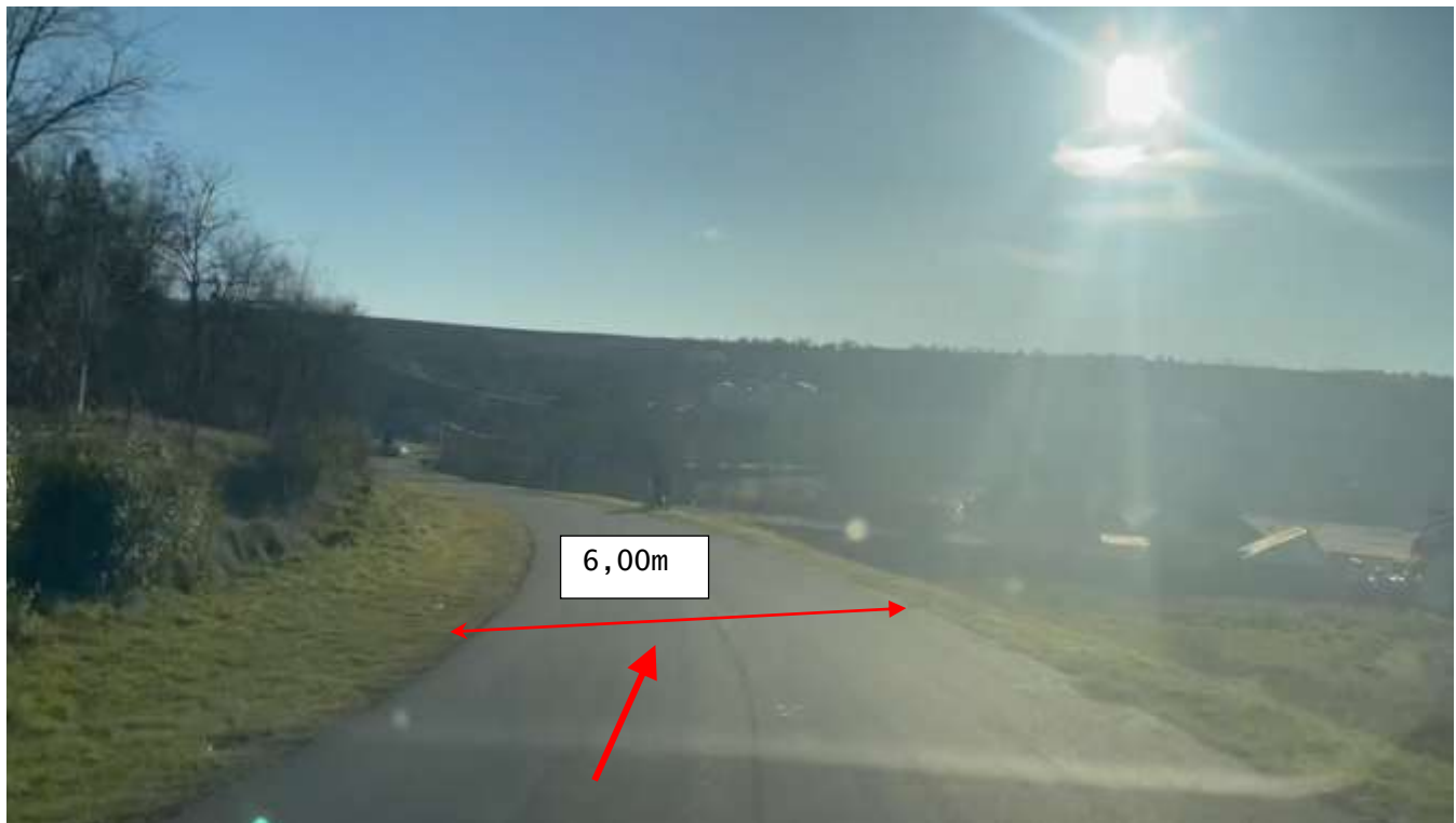
Figura 53. Km 9+900. Sector reabilitat în cadrul proiectului de reparație a drumului, sistemul rutier existent din beton asfaltic în stare satisfăcătoare. Lățimea carosabilului existent ~6.00 m cu acostamente neconsolidate cu piatră spartă cu depuneri locale de namol. Lipsește șanțurile laterale cu consolidare conform tipurilor.
