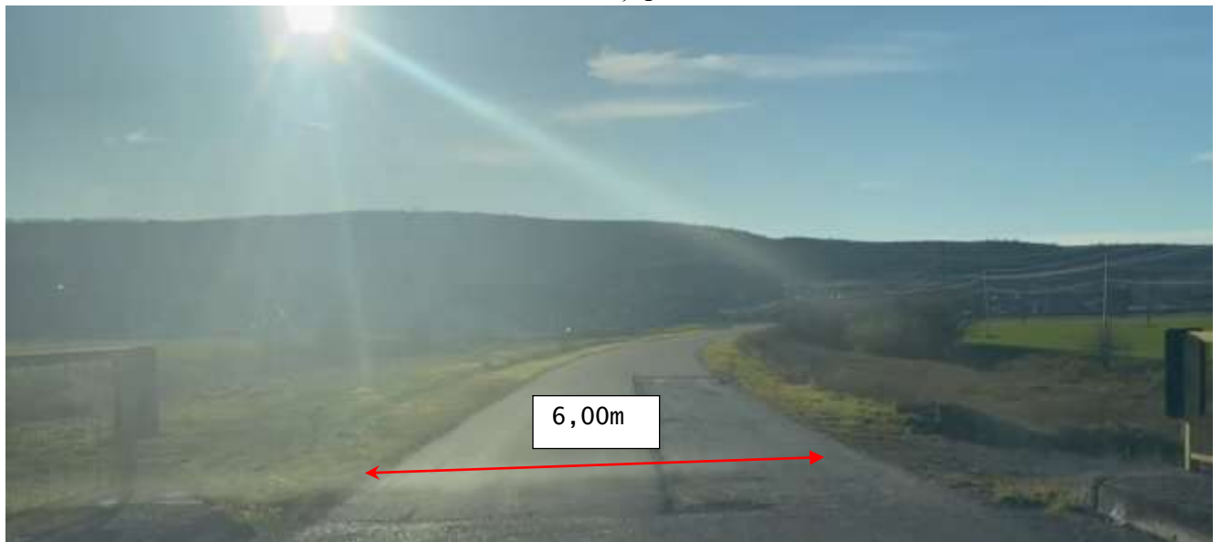
Figura 33. Km 5+275. Sector reabilitat în cadrul proiectului de reparație a drumului, sistemul rutier existent din beton asfaltic în stare bună. Lățimea carosabilului existent ~6.00 m cu acostamente neconsolidate cu piatră spartă cu depuneri locale de namol.
