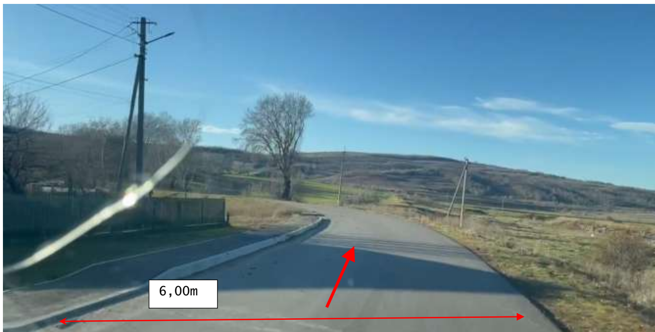
Figura 38. Km 6+300. Sector reabilitat în cadrul proiectului de reparație a drumului, sistemul rutier existent din beton asfaltic în stare bună. Lățimea carosabilului existent ~6.00 m cu acostamente neconsolidate cu piatră spartă.
