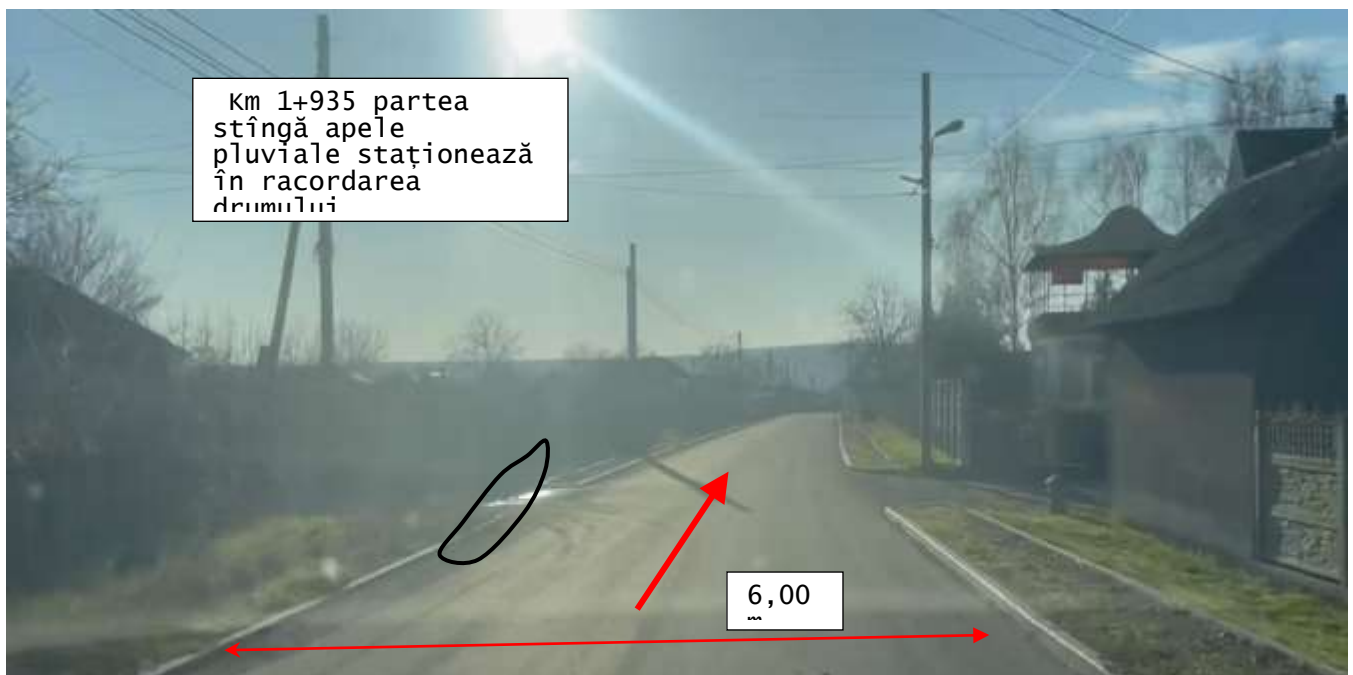
Figura 16. Km 1+935. Sector reabilitat în cadrul proiectului de reparație a drumului, sistemul rutier existent beton asfaltic în stare bună. Lățimea carosabilului existent ~6.00 m. Partea stîngă și dreaptă este amenajată piatră de bordură cu trotuar nefinalizat. Evacuarea apelor de pe carosabil sunt direcționate în străzile laterale cu stagnarea în racordare.
