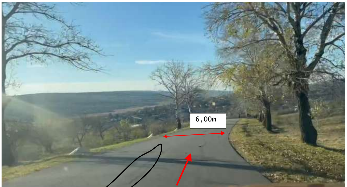
Figura 49. Km 9+300. Sector reabilitat în cadrul proiectului de reparație a drumului, sistemul rutier existent din beton asfaltic în stare satisfăcătoare. Lățimea carosabilului existent ~6.00 m cu acostamente neconsolidate cu piatră spartă cu depuneri locale de namol. Sunt prezente tasări locale pe lungimea Km 9+300 – Km 9+400 m în axul drumului datorată necompactării corespunzătoare a patului drumului sau a infiltrării apelor pluviale de pe versanții din amonte drumului (lipsește șanțul pentru evacuarea apelor meteorice).
