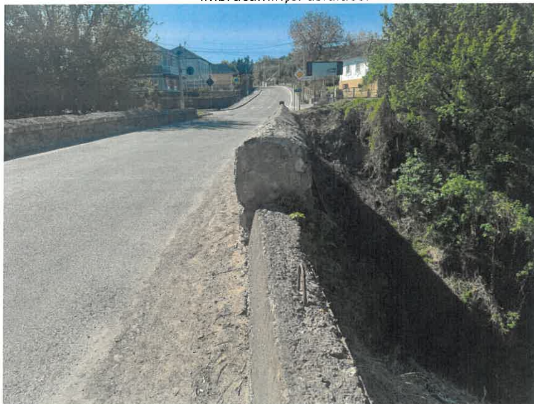
Fotografia 9. Vedere cale (culee nr.2): Tasarea terasamentului, fisurarea îmbrăcăminței asfaltice.
