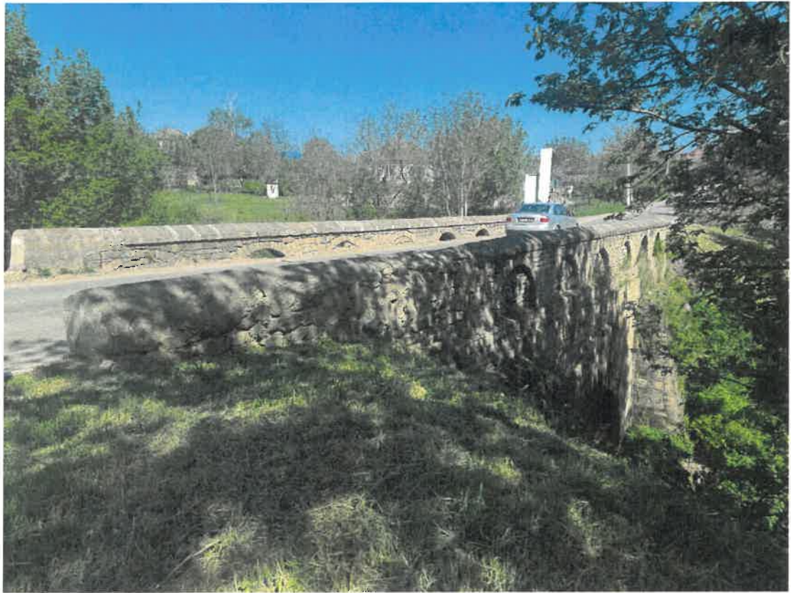
Fotografia 3. Vedere din aval a podului pe direcția Otaci:
