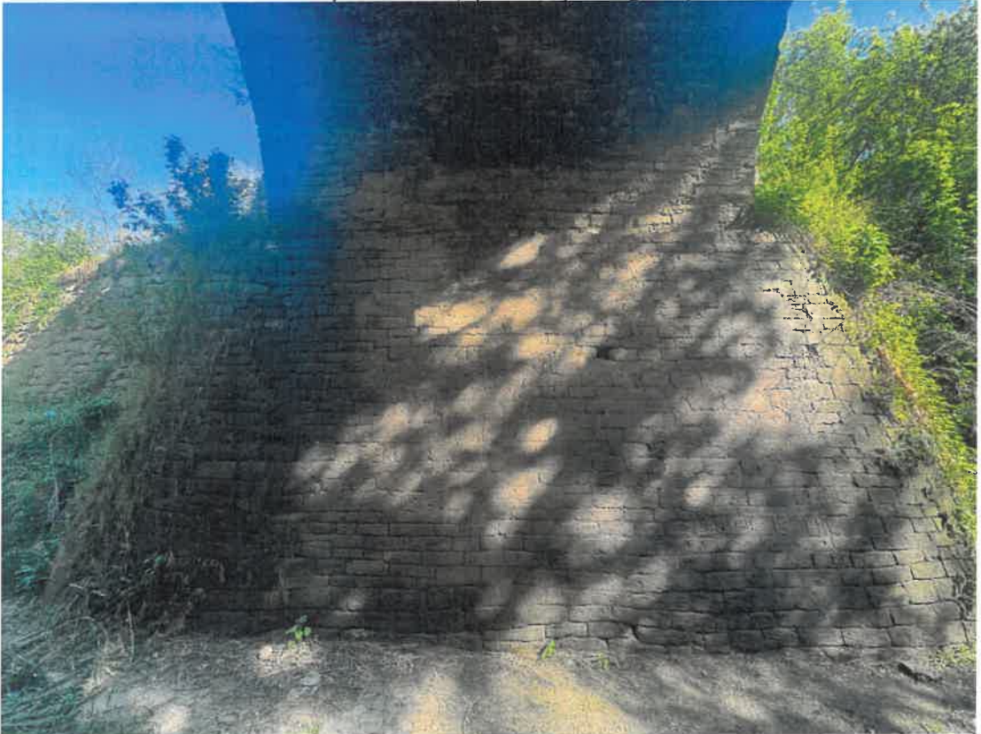
Fotografia 15. Detaliu boltă (amonte): Zidărie degradată, cu căderi de moloane, cu infiltrații masive, prezența vegetației.
