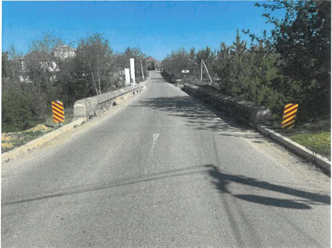
Fotografia 7. Vede cale pod, pe direcția Otaci: Lățime necorespunzătoare lipsa trotuarelor, evacuarea proastă a apelor.
