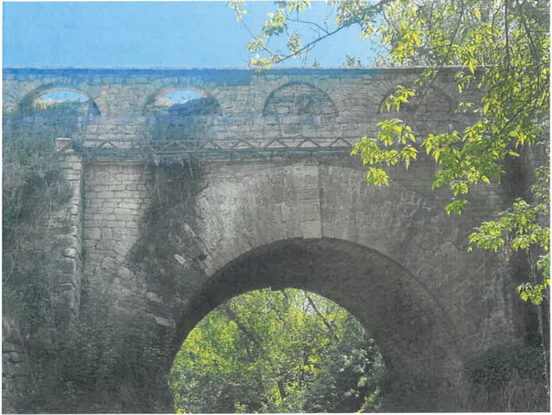
Fotografia 15. Detaliu boltă (amonte): Zidărie degradată, cu căderi de moloane, cu infiltrații masive, prezența vegetației.
