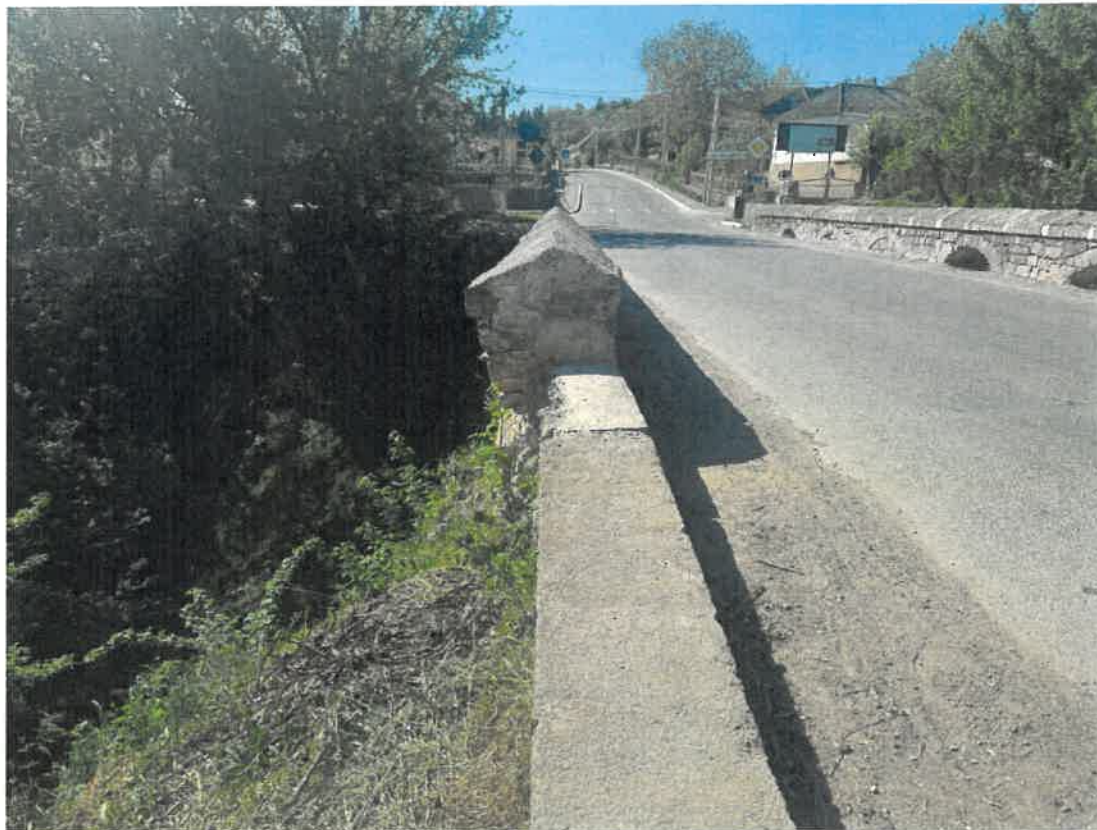
Fotografia 11. Detaliu parapet pe dreapta: Parapet cu deformații în plan vertical, mutilarea parapetului, material solid pe cale.
