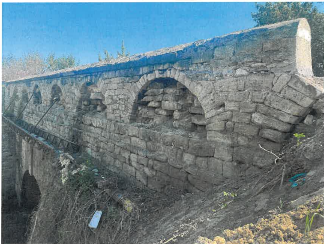
Fotografia 13. Vedere din amonte parapet pe stânga: Zidărie degradată/mutilată, cu infiltrații, prezența vegetației.
