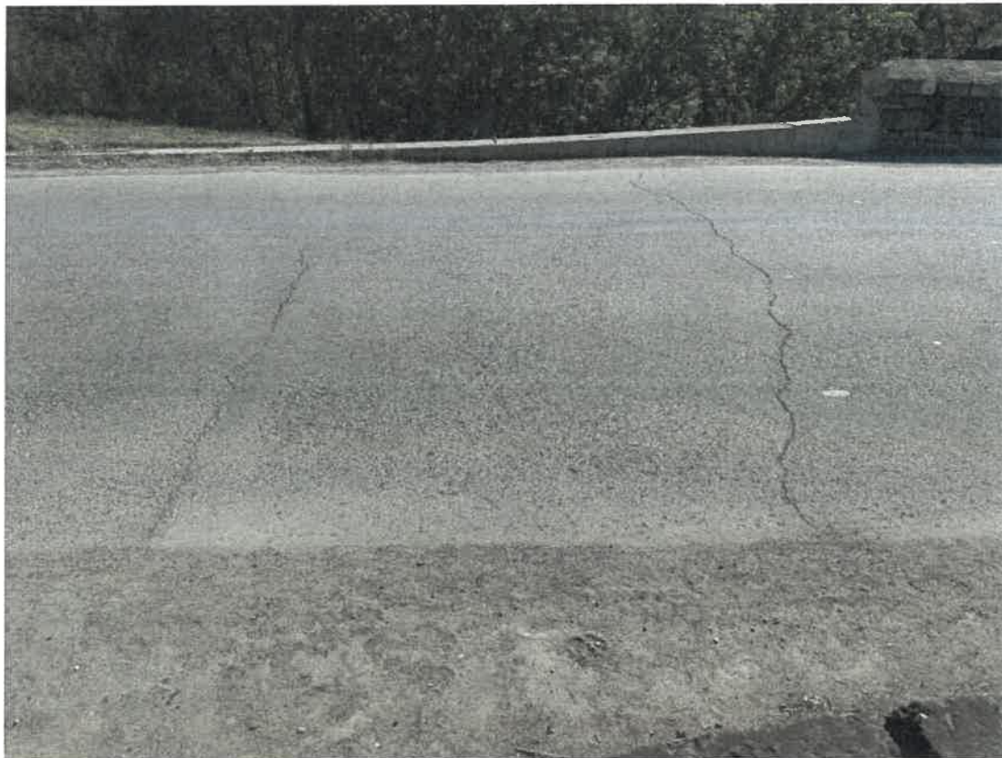
Fotografia 9. Vedere cale (culee nr.2): Tasarea terasamentului, fisurarea îmbrăcăminței asfaltice.
